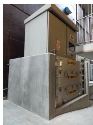
止水版の設置
